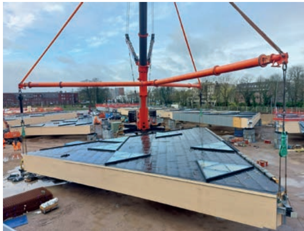
Boven: de driehoeken waren op de punten – bij de consoles voor de oplegging – voorzien van hijsogen (foto: Mart Stevens).
