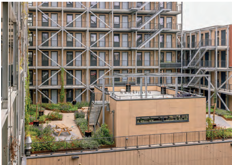
Het paviljoen op de tweede verdieping heeft een dakterras met een pergola. De bewoners kunnen de ruimte huren de daktuin er omheen is gemeenschappelijk.
