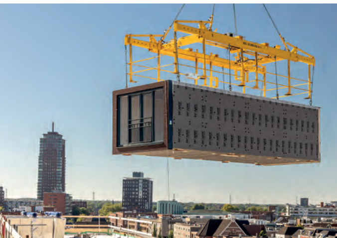
De modules van ruim 11 meter lang zijn kokers van CLT met een gevelvulling van kozijnen en HSB-elementen.
